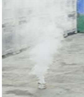
Desinfección de los silos previamente vaciados mediante **MIDA® AIRFUM**, desinfectante fumígeno cuya combustión libera humo a base de ac. Glicólico que desinfecta el interior del silo por contacto.
